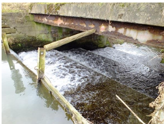
Obrázek 12 Výtok z bezpečnostního přelivu (pohled shora)
