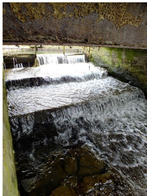
Obrázek 13 Výtok z bezpečnostního přelivu (pohled zespoda)
