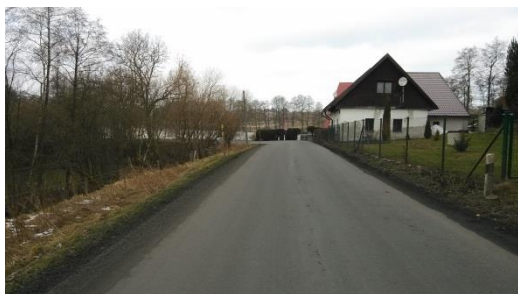
Obrázek 10 Silnice III/3443 – objekt č.p. 78 – začátek řešeného úseku
