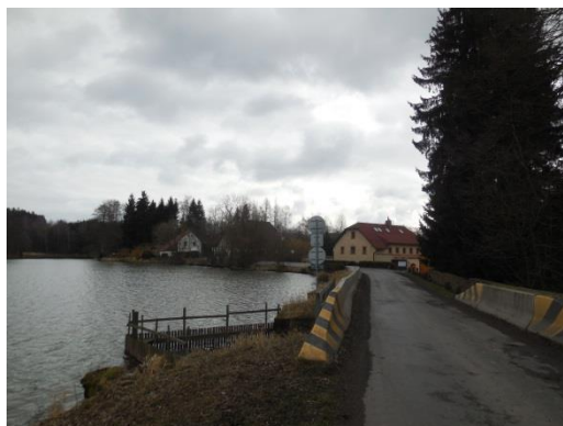
Obrázek 11 Pílský rybník – silnice III/3443 procházející po hrázi – bezpečnostní přeliv rybníka – objekt č.p. 86 (konec řešeného úseku)
